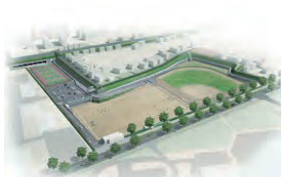
野川大沢調節池(三鷹市)
