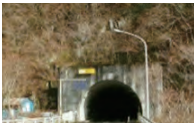
日原トンネル
