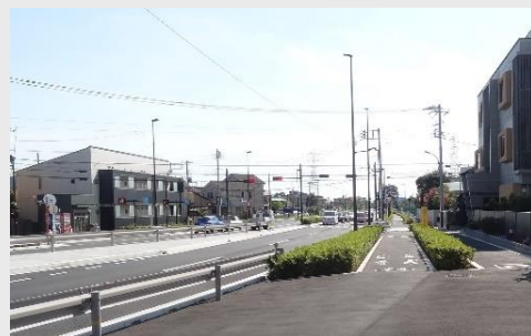
〔東八道路（三鷹 3・2・2）の整備状況〕
