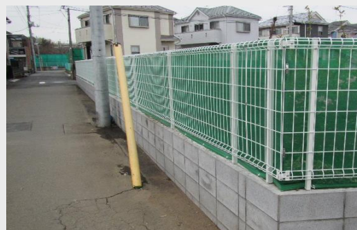
〔土留め・フェンス〕
